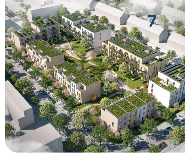
Holzhybridbauweise und begrünte Fassaden – urbane Architektur mit ökologischer Wirkung.
